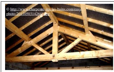
Cette ferme fait partie d'une charpente supportant un toit. On considère ici une seule ferme et la part du poids de la toiture qu'elle supporte. Le problème est considéré plan. Le poids de la toiture est transmis aux axes A, B, M et aux axes symétriques A', B'. Le poids total est égal à  $4.P$  ( $P$  correspondant au poids d'une largeur  $L$  de la toiture). Ce poids est réparti sur les axes comme indiqué ci-dessus. Il est équilibré en A et A' par des réactions d'appuis/murs,
